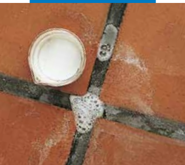
Limpieza de eflorescencias
